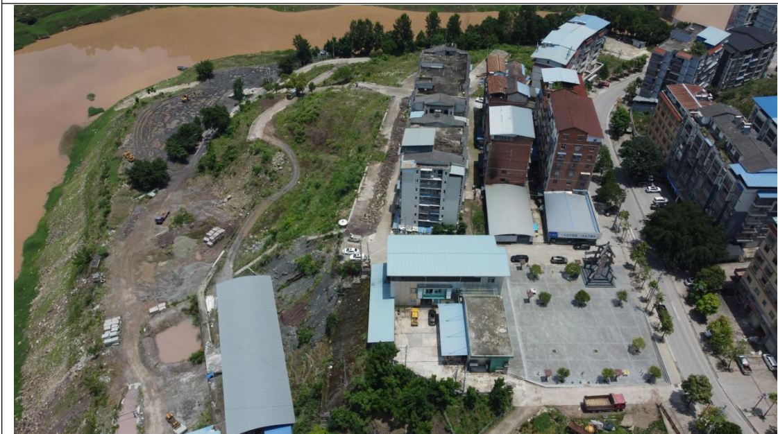
调查地块西南侧龙角镇供电所办公用房及五龙社区居民点
