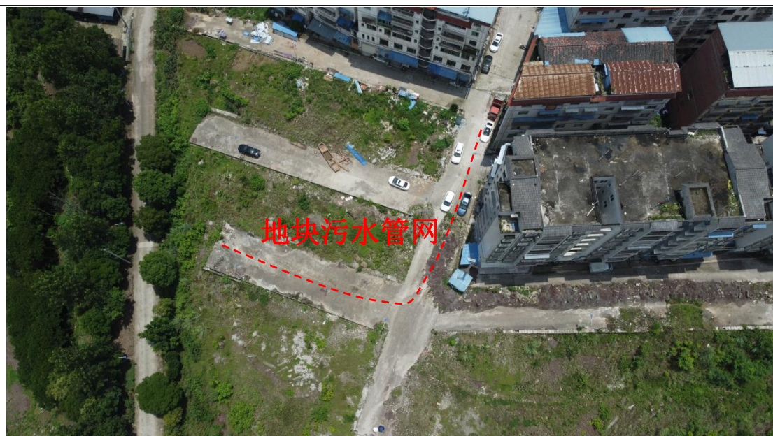
调查地块内污水管网
